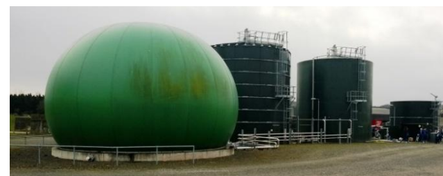
Biogazownia o mocy 60kWe przetwarzająca gnojowicę, Hillsborough, Irlandia Północna
